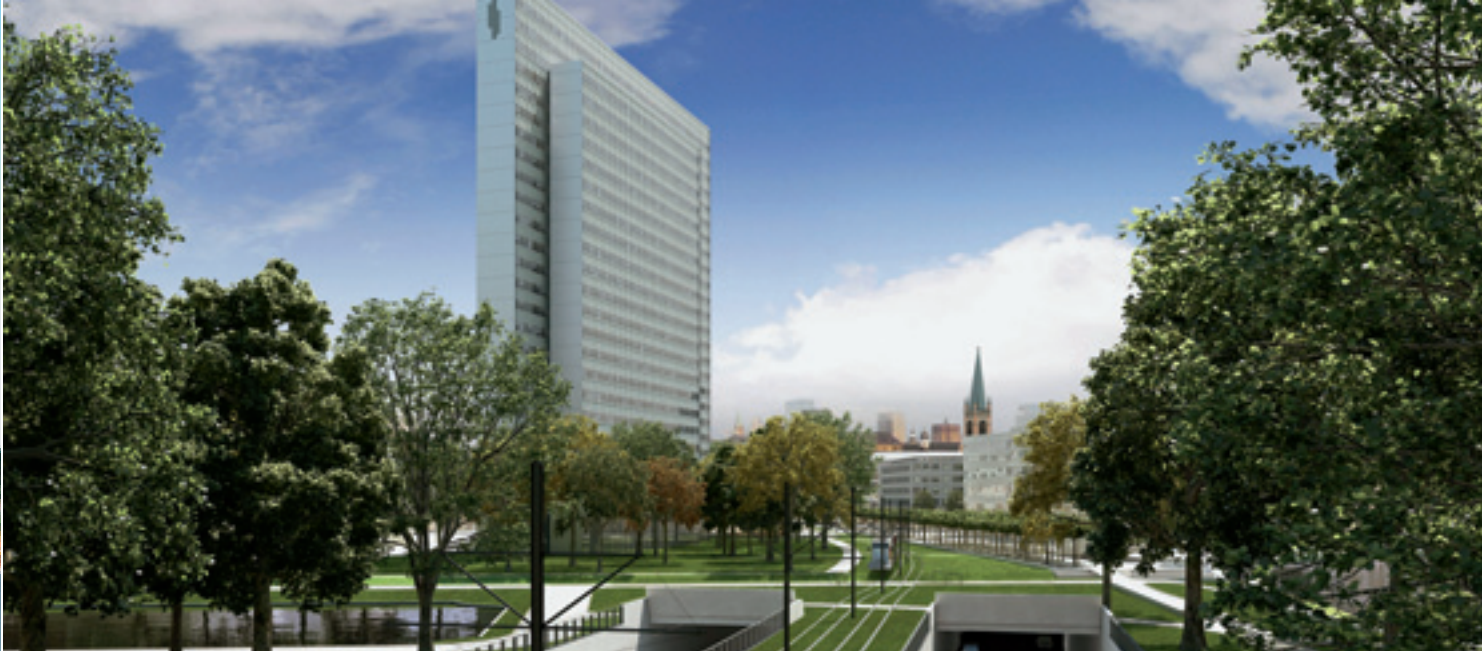
Das Dreischeidenhaus in Düsseldorf wird nach einer Komplettisanierung zirka 35.000 Quadratmeter Bruttogrundfläche in hochwertiger, moderner Ausstattung bieten
