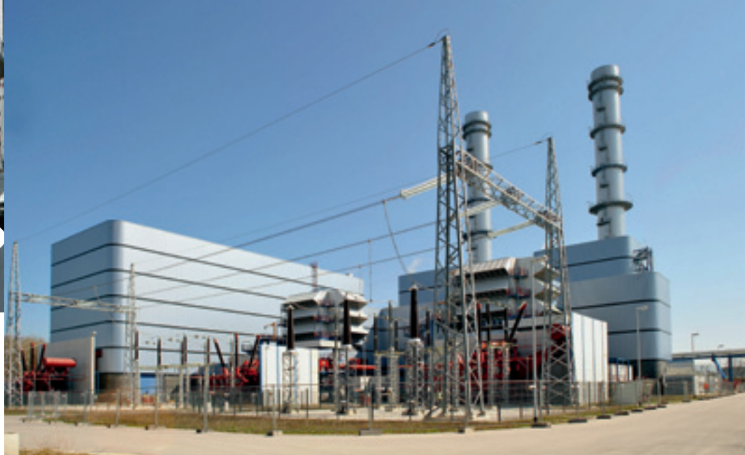
Gas- und Dampf-Kraftwerk Irsching
