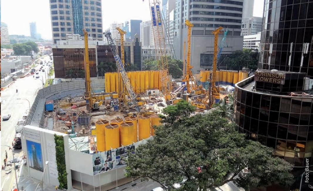
Bei dem Projekt Market Street Tower in Singapur stellte die malaiische Tochter von Bauer Spezialtiefbau mit bis zu vier Bohrgerten erst eine überschrittene Pfahlwand für die Baugrube und anschließend die Gründungspfähle für das Gebäude mit Durchmessern von 3,5 Metern her.
