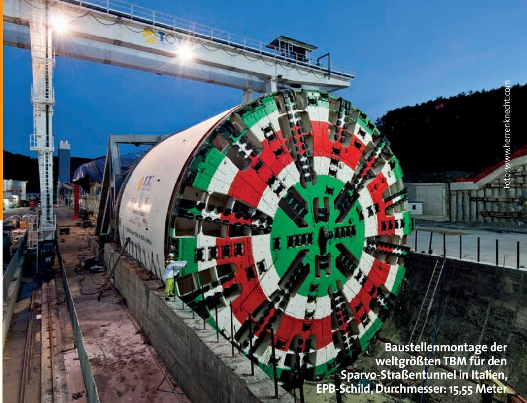
Baustellenmontage der weltgrößten TBM für den Sparvo-Straßentunnel in Italien, EPB-Schild, Durchmesser: 15,55 Meter
